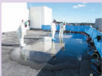
●高圧洗浄の様子
